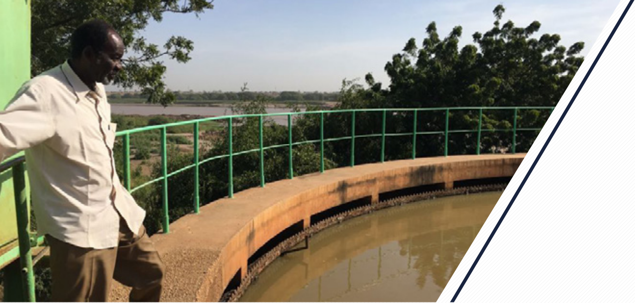
■ El İncifav Köyü Su Temini Projesi
